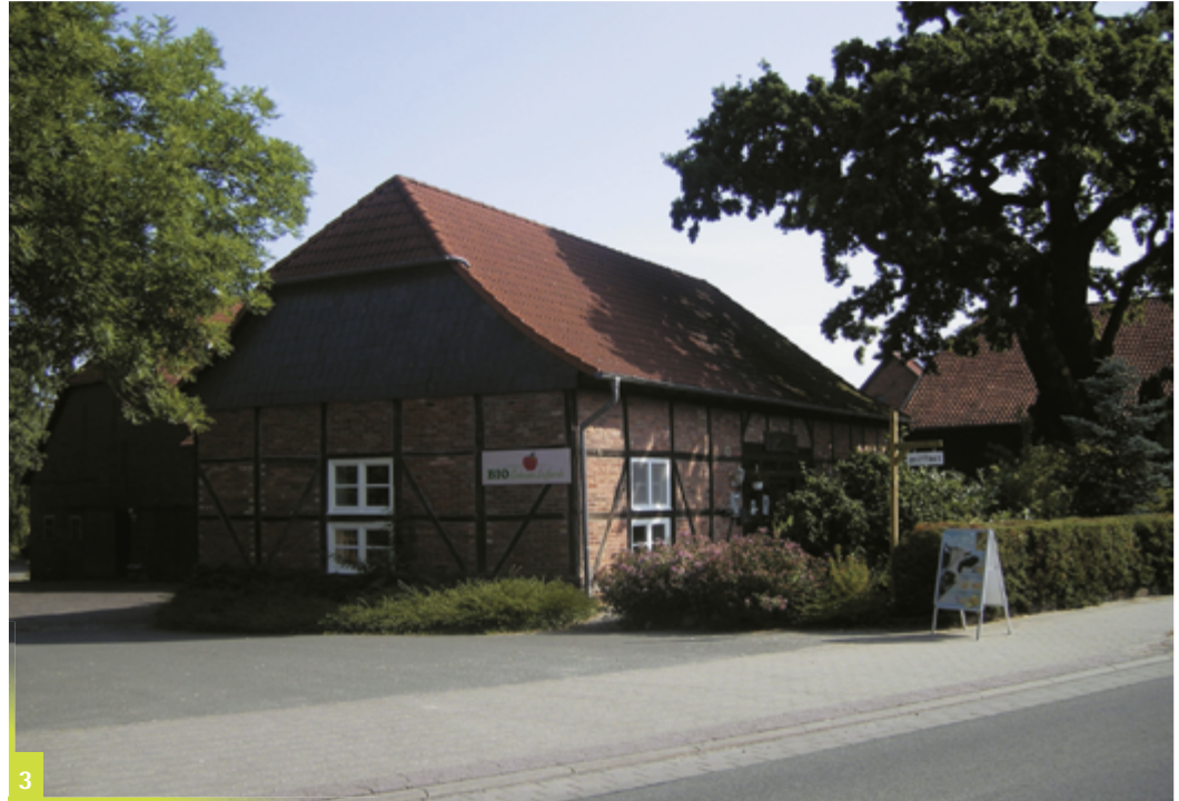
Abbildung 3 Beispiel für die Umnutzung einer ehemaligen Scheune in einen Bioladen: die Bio-Scheune in Leiferde. Foto: Linda Funke
