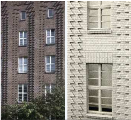
Mit der 3D-Drucktechnologie lassen sich filigrane Bauwerke wie die reich profilierte Ziegelfassade des Poelzig-Baus in Hannover präzise nachbilden.
