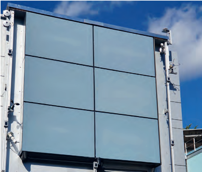
Bei Gewerbebauten gut einsetzbar und von herkömmlichen Fassaden optisch kaum zu unterscheiden: PV-Module als Fassadengestaltung. Foto: Wegener
