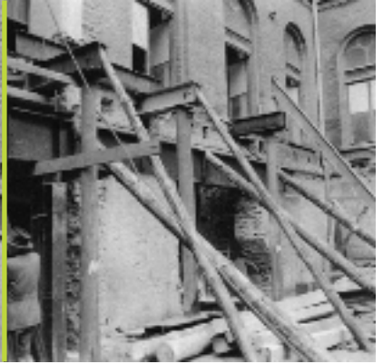
Mittig und rechts: Die Sanierungs- und Umbauarbeiten im Lichthof
